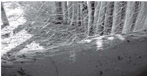
Foto: Robério dos Santos Sobreira
